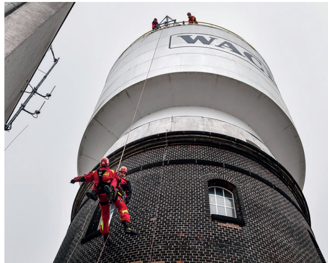
Abseilen vom 26 Meter hohen Wasserturm
